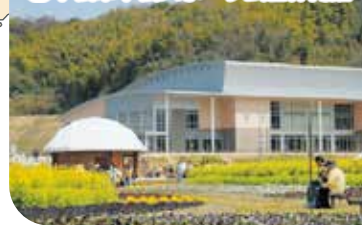
9 下松市下松スポーツ公園体育館
